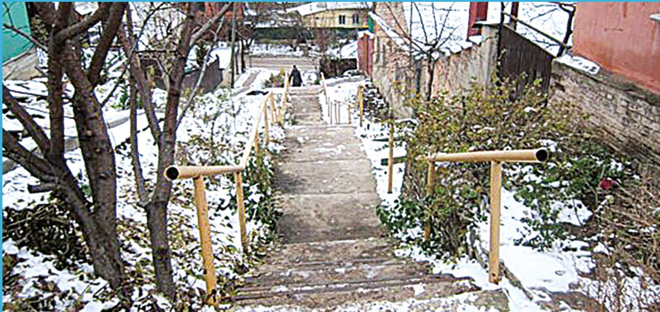
**ВОССТАНОВЛЕНИЕ ПОДПОРНОЙ СТЕНКИ (28 П.М.), РЕМОНТ СТУПЕНЕЙ И ПОРУЧНЕЙ,
